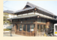
20 師岡家住宅 (近代和風建築/住宅/大正初期) 三島由紀夫著「美しい星」の冒頭にある館。
