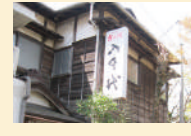
28 八千代 (近代和風建築/小料理/昭和27年) 室内には大工の技の見せ場があちらこちらに。
