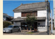
23 銀河堂 (店蔵建築/店舗/明治中期) 店前の庭はかつて「縄市」が開かれていた。
