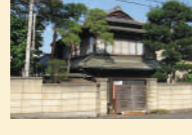
22 個人宅 (近代和風建築/住宅/大正10年) 2階屋根破風板中央に「懸魚(ゲギョ)」あり。
