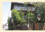
26 畑屋 (近代和風建築/料亭/大正初期) 歴史建物で木造3階建ては、ここだけ。
