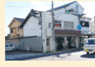
21 ナカヤ (町屋建築/店舗/明治期) 瓦屋根の町屋建築として貴重。
